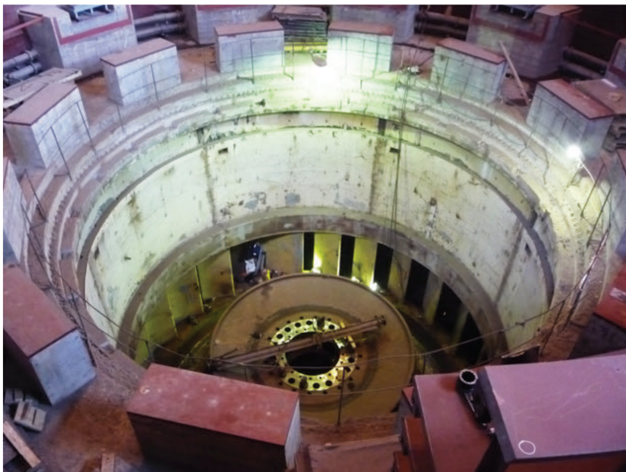
Рис. 3. Посадочное место гидравлической турбины.
